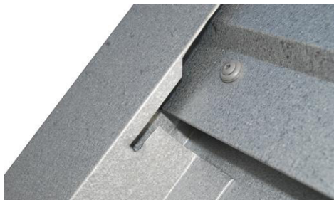
Vindskivan skjuts över nocken.
