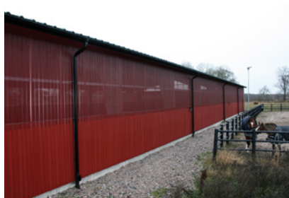
Perforerad plåt släpper in ljus och ger ventilation i hallen.
